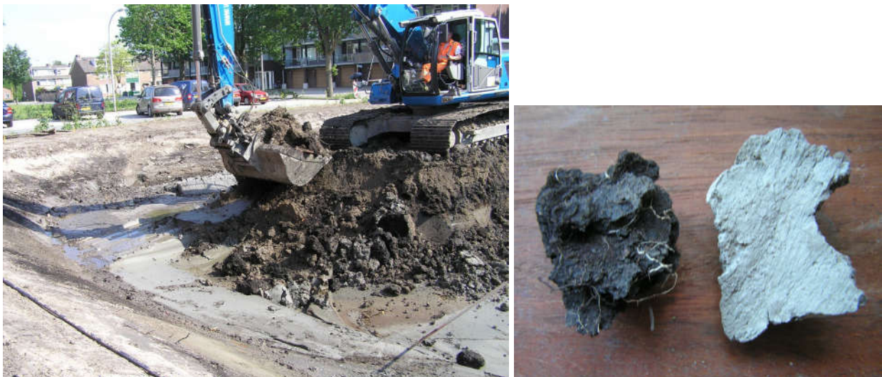
Figuur 2 Vijver in aanleg
